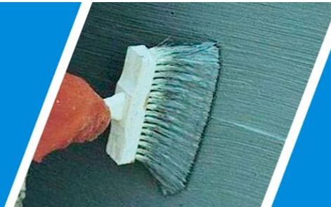
Непрочные, отслаивающиеся участки, а также ранее нанесенные отделочные материалы должны быть удалены. Обрабатываемая поверхность должна быть очищена от пыли, грязи и прочих веществ (масла, плесень, цементное молоко и др.). Данные операции можно проводить как вручную с помощью стальных щеток, так и механическим способом с помощью пескоструйных или водоструйных установок высокого давления, электродрелей, перфораторов. При очистке поверхности по возможности создать шероховатую структуру.
